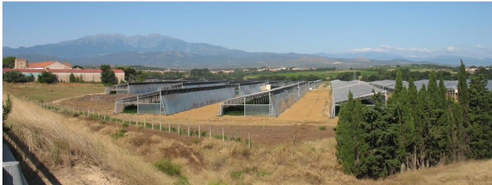
☞ Photographie : Serres photovoltaïques
