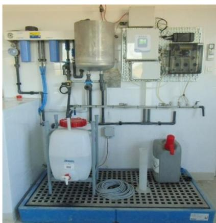
Cet équipement permet, en fonction de la concentration de l'effluent entrant, d'orienter la pollution sur la filière afin d'optimiser son traitement :
